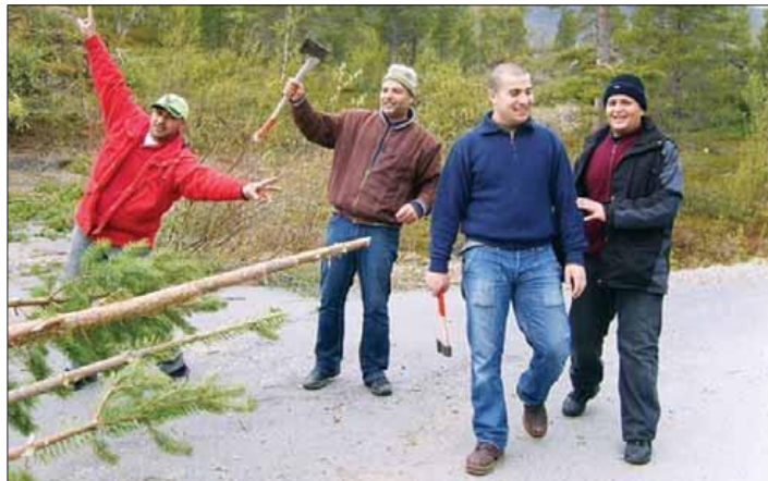
KVISTET MED GODT HUMØR: Murad Sobeih, Mustafa Shat, Eihab Al Nimr og Thear Badawi fra Palestina sto på med byggingen på Kvenvikmoen.
